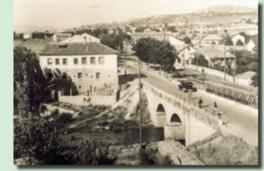
2. Collado Villalba 1952. La vía del Tren del Berrocal a su paso por la Calle Real. A la derecha se puede observar el puente metálico sobre el río Guadarrama. Tenía una longitud de 16 metros construido en hierro, con estilo constructivo característico de siglo XIX. El asiento de la vía estaba cubierto por travesaños de roble.
